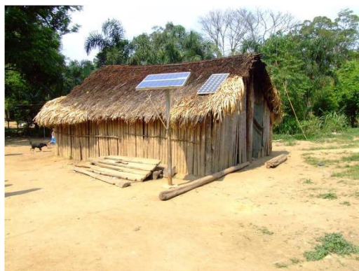
Foto 66 - Casa de apoio a atendimento de saúde com painel fotovoltaico (Foto: Mauricio A. Marinho)
